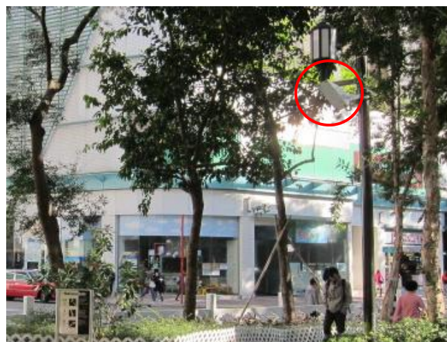
在公園燈柱上安裝射燈
